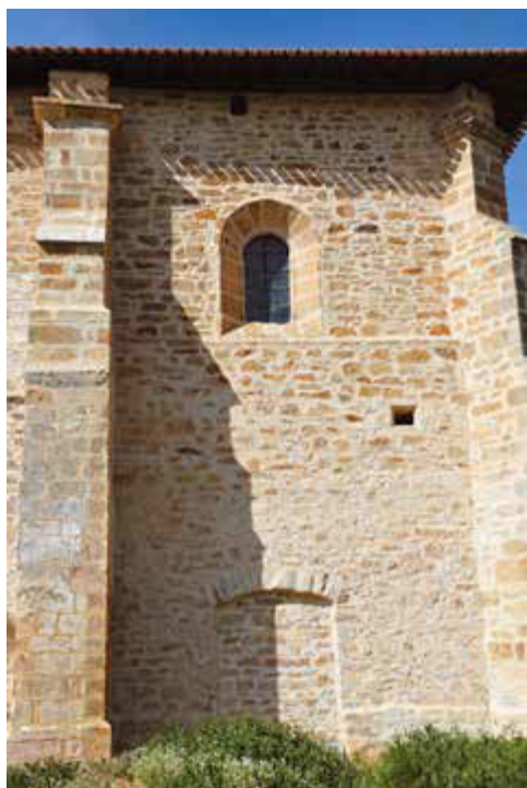
DETALLE DE LA PUERTA TAPIADA Y DE UNA PEQUEÑA VENTANA.
